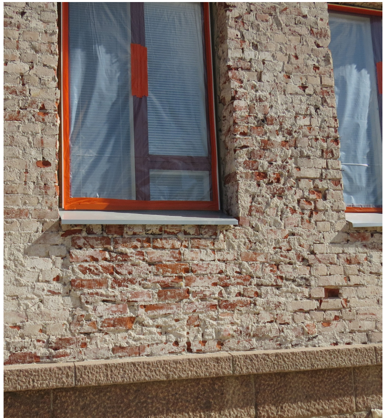
Koulun saneerauksen yhteydessä 2016 paljastui rappauksen alta korjattu seinäkohta. (kuva Alpo Tuomi)
